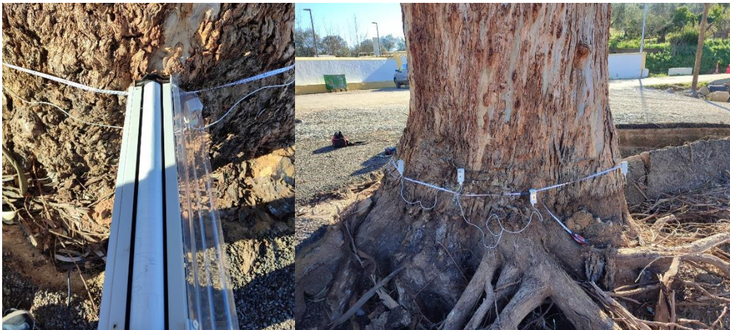
Figura 4 – Sondagem realizada com resistógrafo (a) e tomógrafo (b) na base da árvore
