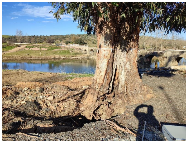
Figura 8 - Pormenor do colo e tronco evidenciando a zona de fendilhamento e podridão.
